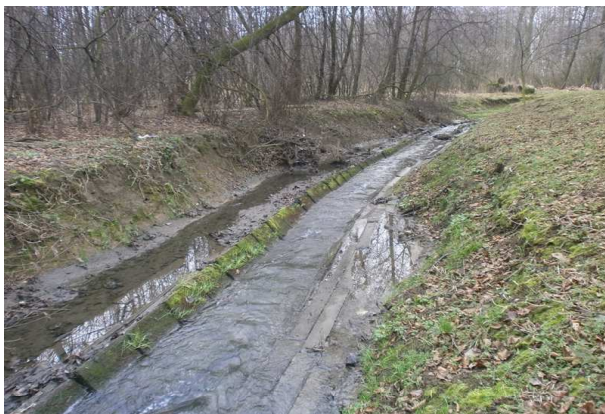
Obr. 7: Opevnění dna toku betonovými panely, km 4.050, pohled po proudu
